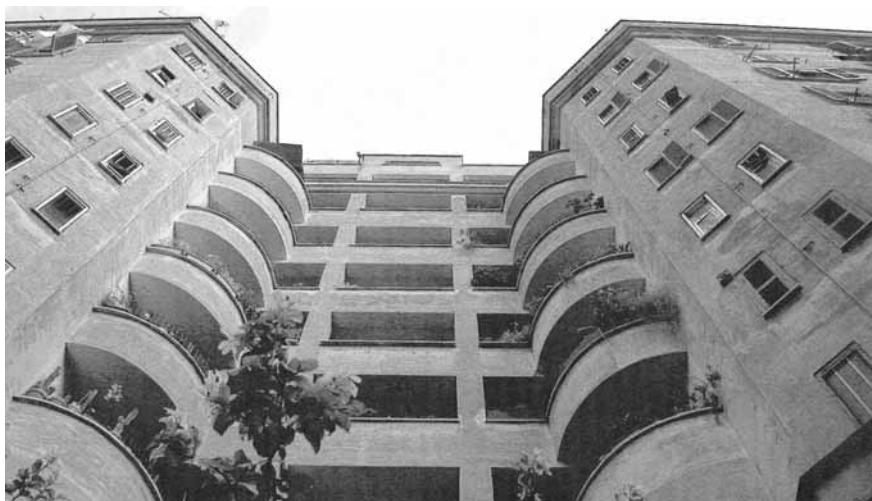
Parte del complesso di via di Donna Olimpia 30, vista dal cortile (Foto S.Cecchini 2002)
